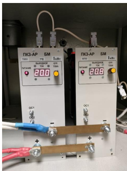
Рисунок 3 – Два базовых модуля электрохимической защиты соединённые параллельно с номинальными характеристиками 48В, 40А
